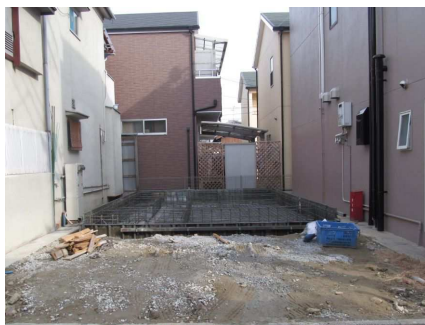
風景=物件の土地、コンクリ施工後
