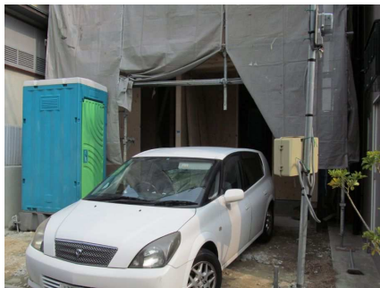
風景=木造建築途中
